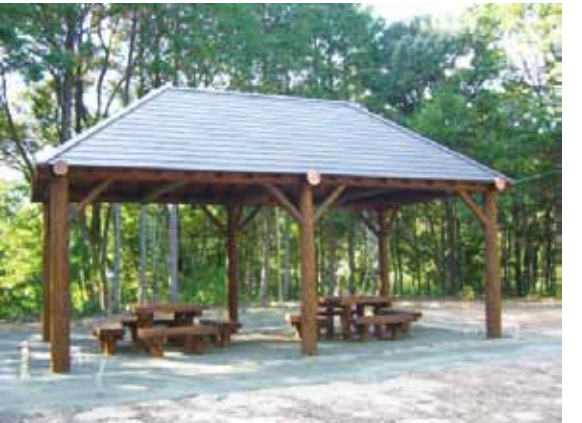
完成した東屋
